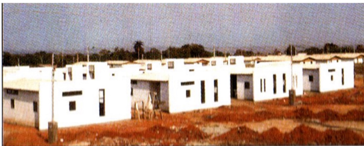
Figura 5 – Cooperativa Habitacional Sargento Wolf – vista geral das casas construídas no Gama.
